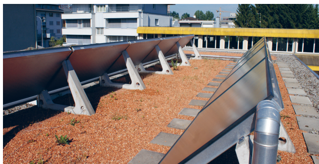
Collecteurs solaires montés sur des supports en béton. Les plaques de passage protègent le système d'étanchéité lors des travaux d'entretien et de maintenance.
