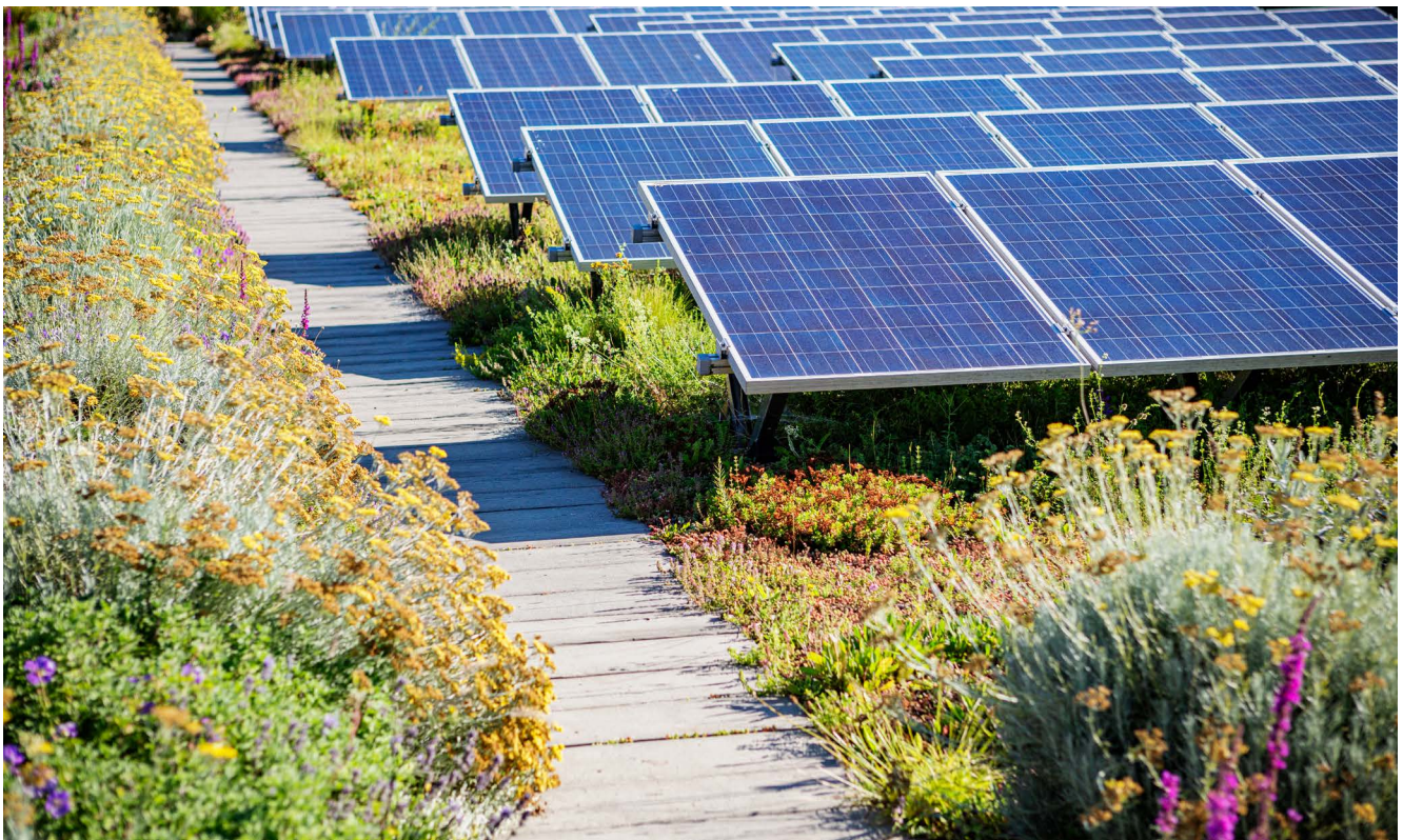
Figura 3: combinazione di inverdimento estensivo/intensivo del tetto accanto a impianto fotovoltaico, fonte: Contec
