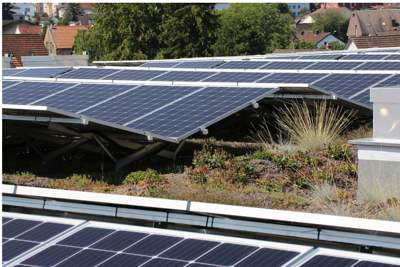
Figura 16: impianto fotovoltaico orientato a est/ovest con substrato modellato di diverse altezze, fonte: Zinco
