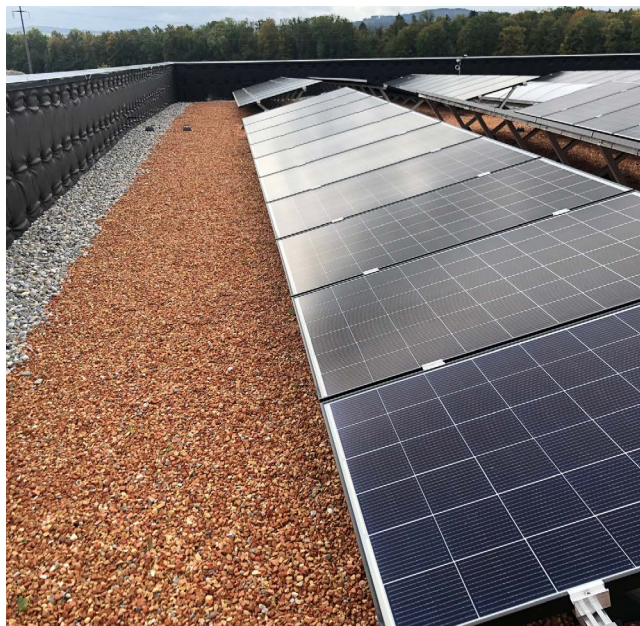
Figura 5: L'impianto fotovoltaico deve essere installato a sufficiente distanza da elementi strutturali adiacenti, attacchi a parete e simili, fonte: Contec
