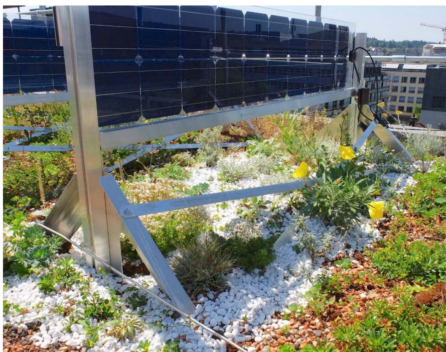
Figura 7: impianto fotovoltaico con moduli bifacciali della residenza per anziani Eichgut, Winterthur. Un suolo chiaro con piante dalle foglie argentate, come eliantemo e timo, favorisce la riflessione della luce solare e genera una resa maggiore nella produzione di energia solare. Fonte: Solarspar
