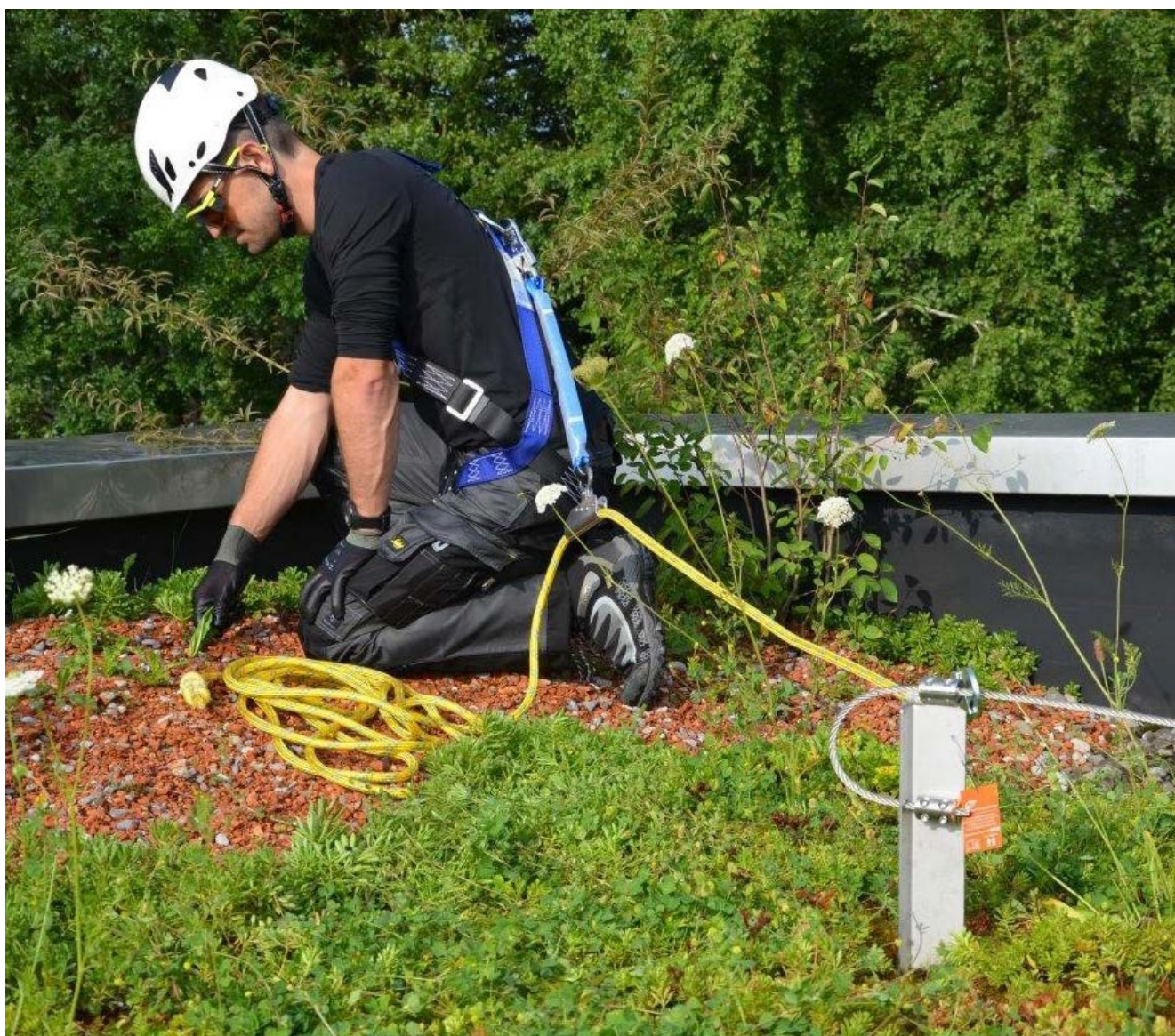
Figura 20: sistema di protezione di lavoro e persone durante gli interventi di manutenzione dell'inverdimento e degli impianti solari, fonte: Contec
