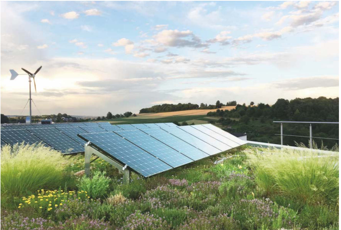
Figura 10: combinazione di inverdimento estensivo/intensivo del tetto accanto a impianto fotovoltaico, fonte: Zinco
