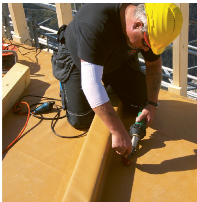
Fig. 3: Sigillatura completa del controlistello con membrane saldate.
