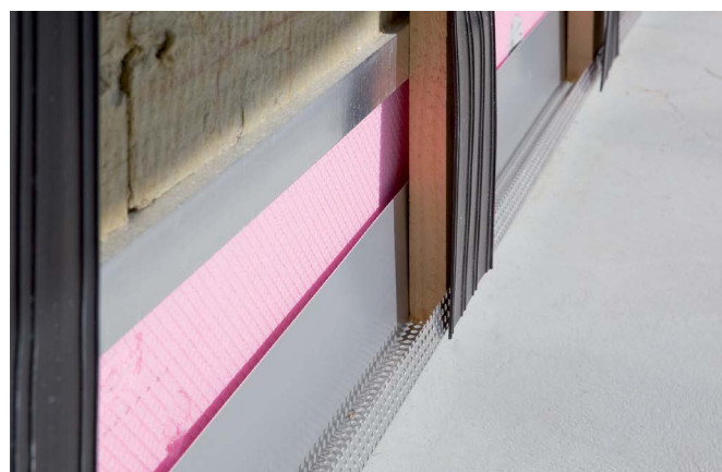
Fig. 1: isolamento dello zoccolo con lastre di XPS
