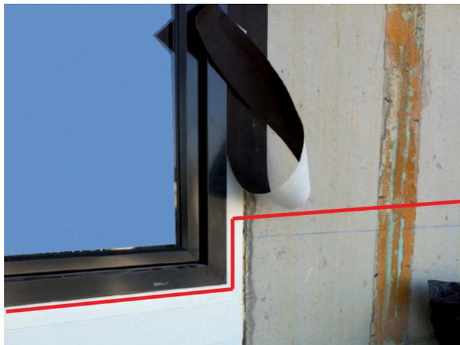
Fig. 20: nell'area dei risvolti le bande ermetiche sono da fissare solo dopo l'esecuzione dei risvolti
