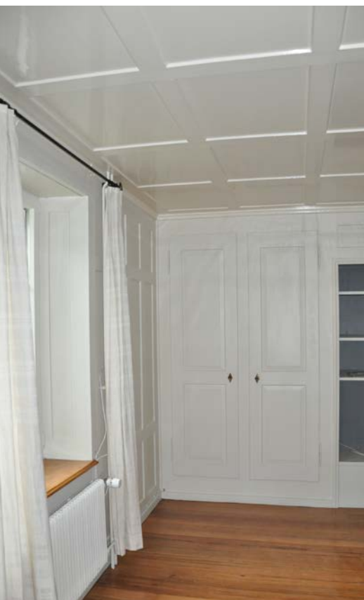
Ausgangslage: Wohnzimmer der Einliegerwohnung vor dem Umbau.
