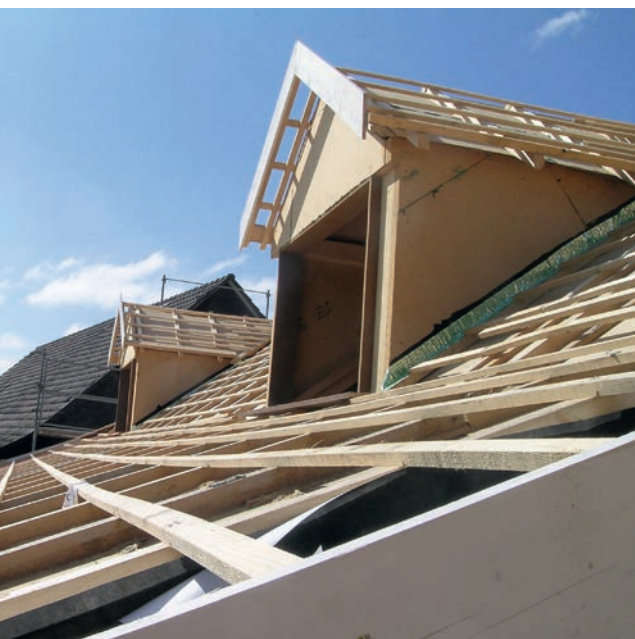
Etappe 1: Lukarne mit 60 mm Weichfaserdämmung und Glaswolle zwischen den Sparren gedämmt.
