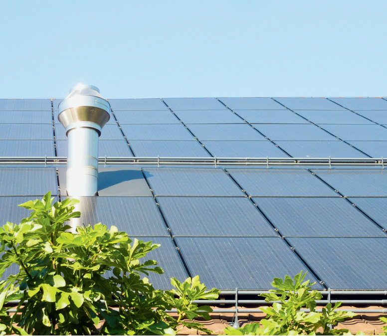
Abb. 1: Beispiele von typischen Abschattungssituationen auf Dächern.
