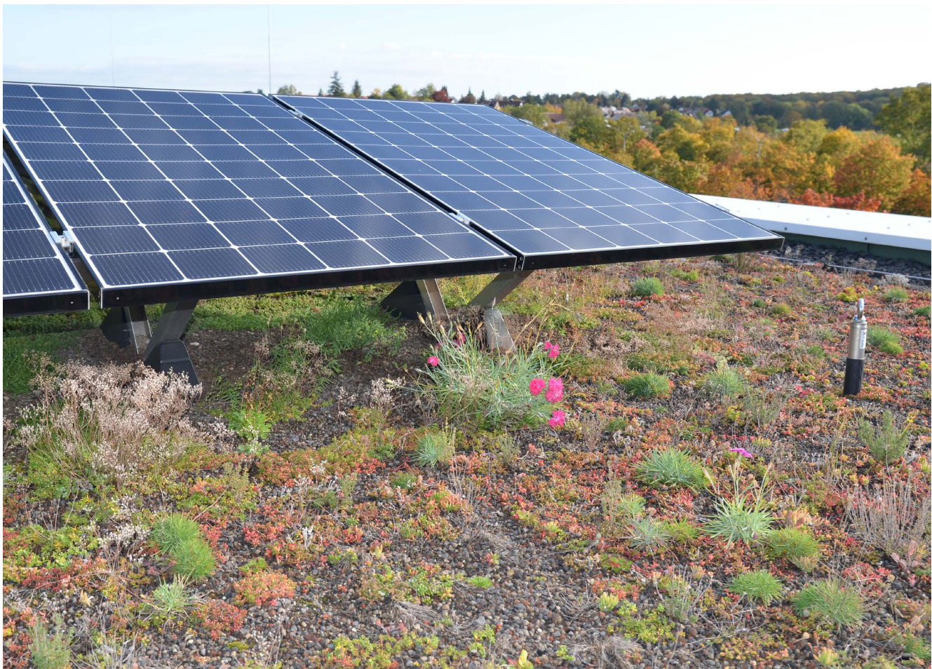
Figure 21: Dispositif de protection contre les chutes, source: Contec
