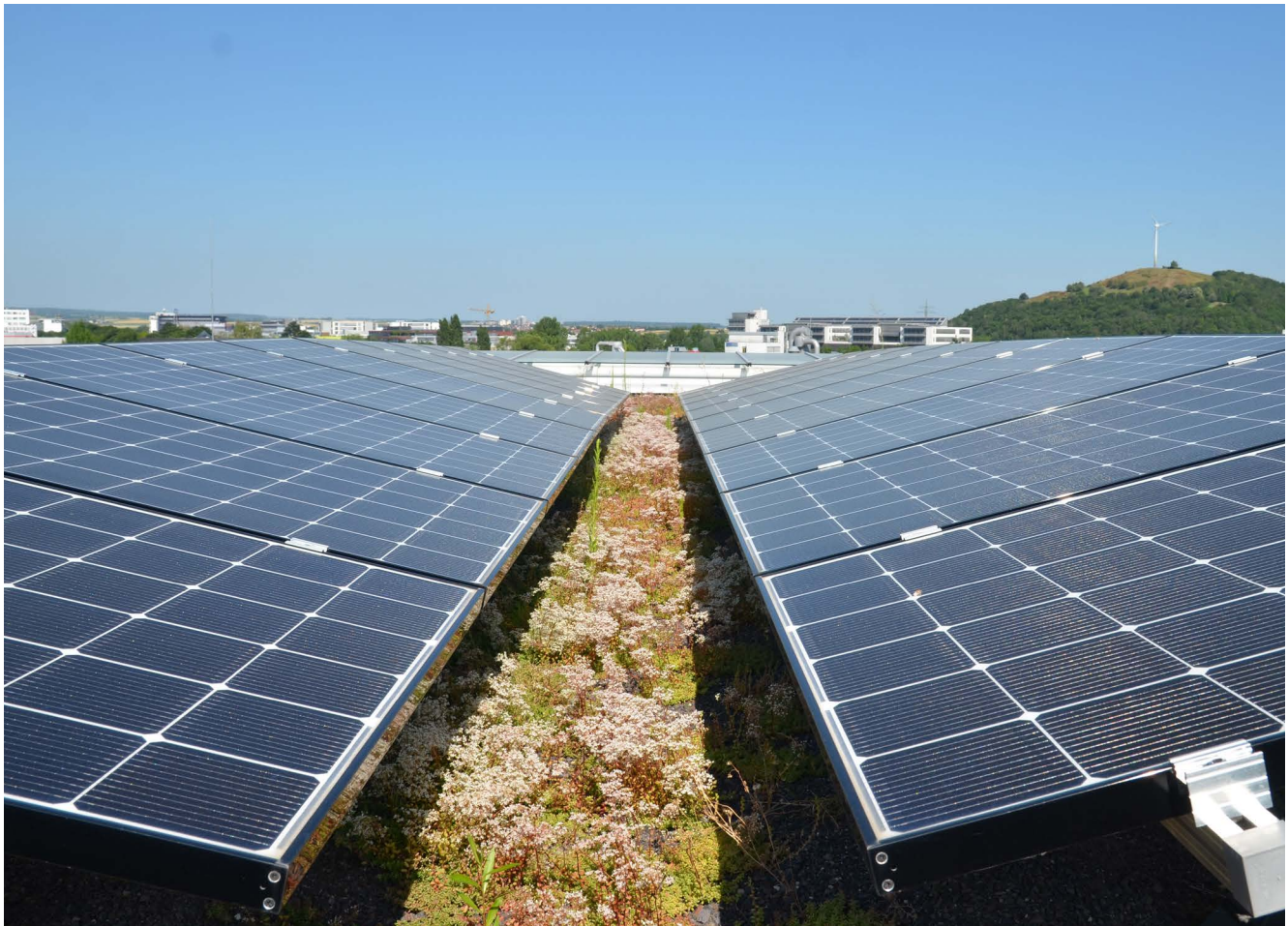
Figure 13: Installation PV orientée à l'est/ouest avec une structure de substrat minimale, source: Bauder
